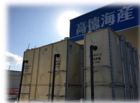
▲滅菌海水用タンク 専用トラックで海から汲んだ海水を、特殊フィルターで濾過し、さらに殺菌します。工場内に配管され、魚の洗い水や、下味付け等の塩水として使います。
